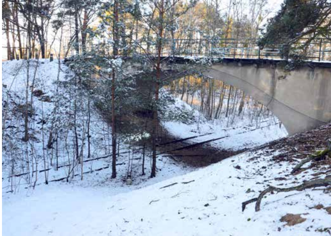
Wiadukt kolejowy przy drodze z Trzciela do Prądówki
