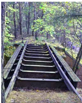
Pozostałości linii kolejowej z Międzychodu do Zbąszynia w okolicach Prądnówki
