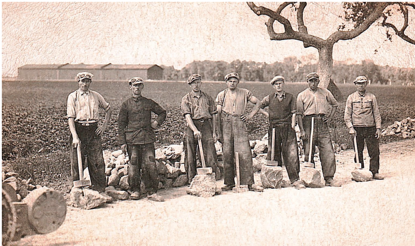
Budowa niemieckiej autostrady w czasie II wojny światowej, okolice Bolewic
