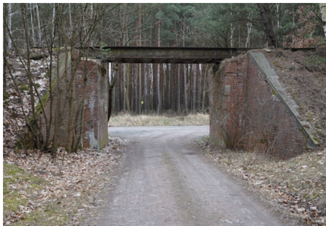
Wiadukt kolejowy w okolicach Prądówki
