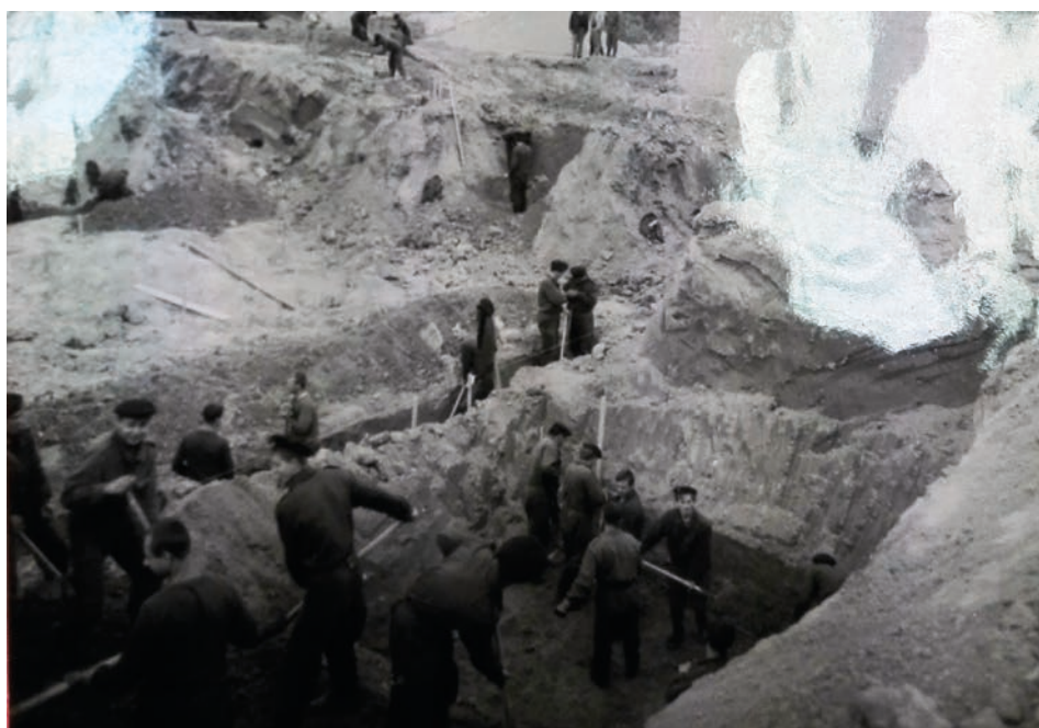
Ręczne kopanie fundamentów pod nową szkołę w Bolewicach
