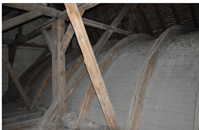
Konstrukcja sklepienia i więźby dachowej kościoła w Miedzichowie
