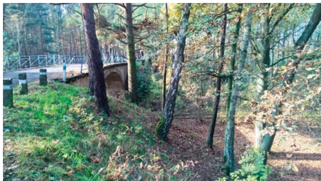
Wiadukt drogowy nad linią kolejową z Miedzichodu do Zbąszynia
