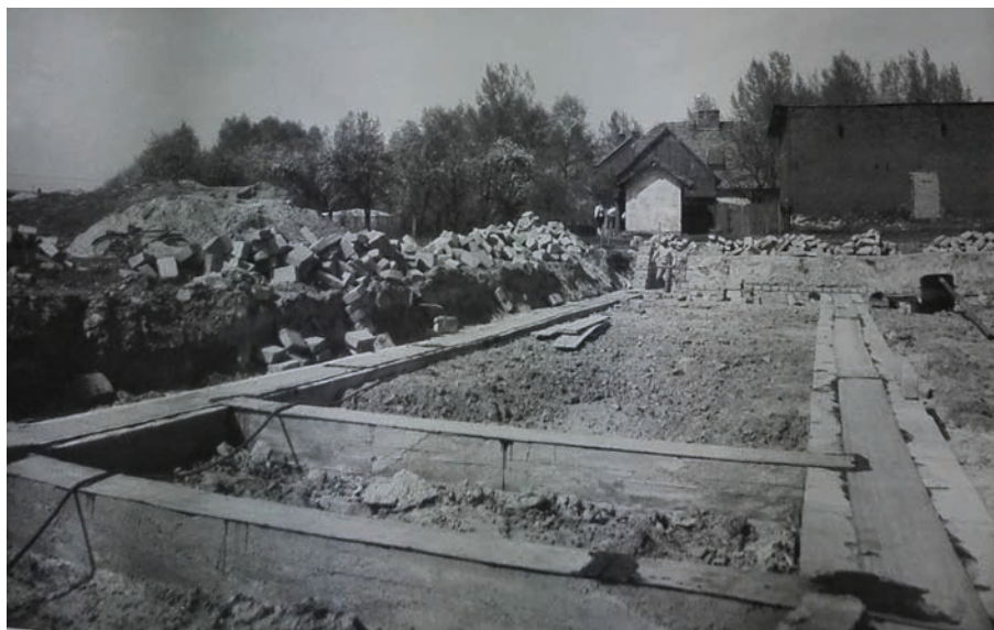
Budowa Szkoły w Bolewicach, budynek A
